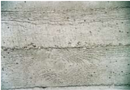
Düşük pigmentli bitiş (dolgusuz), boşlukları açık
