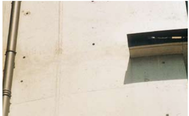
Büyük ölçüde ya da tamamen mineral renk eşleme yoluyla düzeltilen yüzeyler
