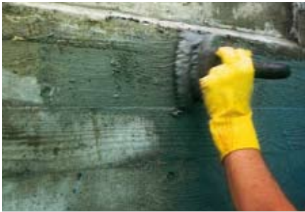
Fırça izleri, kaba tahta kalıp dokusu korunur
