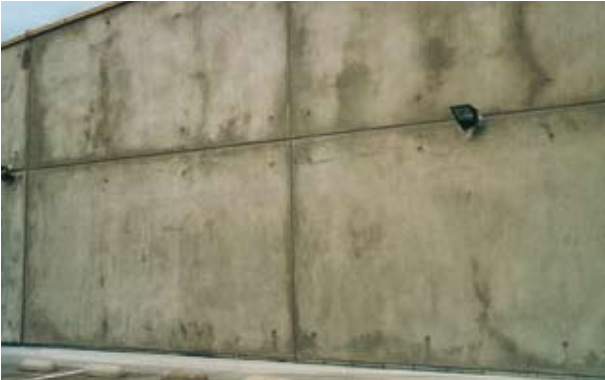
Ağır lekeli yeni beton
