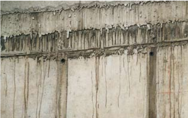
Sıva kusurlarıyla dolgu gerektiren yeni beton
