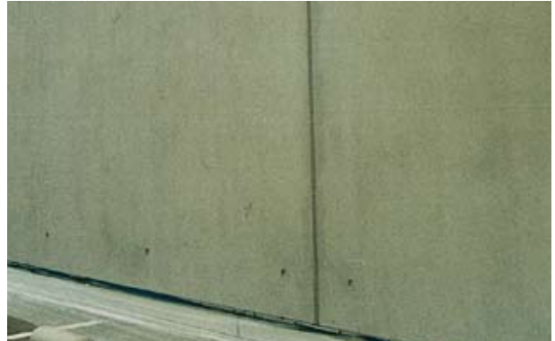
Lekeleri büyük ölçüde kapatan ya da tam olarak örten mineral-renk eşleme sonucu görünümü
