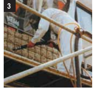
3 IBIX Kumlama Sistemleriyle* çelik takviyenin temizlenmesi. Pas giderme derecesi, DIN EN12944-4 uyarınca Sa 2,5
