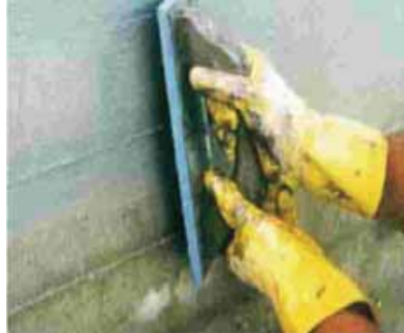
Sünger, sert kauçuk, mala veya kaba tahta kalıp ile oluşturulan doku korunur.
