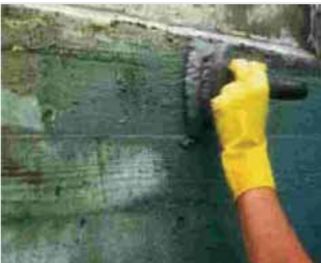
Fırça izleri, kaba tahta kalıp dokusu korunur.
