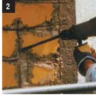
2 Paslanmış çelik donatının açığa çıkması
