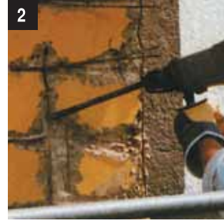
2 Paslanmış çelik donatının açığa çıkması
