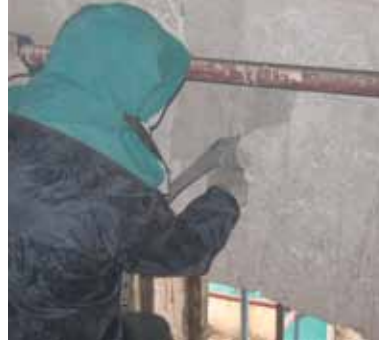
İstanbul: Üsküdar Mihrimah Sultan Camii (M.S. 16. Yüzyıl) Marmara mermeri ve küfeki taşı temizliği
