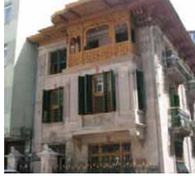
İstanbul: Bakırköy Kont Allion Konağı (M.S. 19. Yüzyıl) Sıvalı yüzeylerin temizliği
