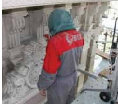
İstanbul: Dolmabahçe Sarayı Saat Kulesi (1895) Küfeki taşı temizliği
