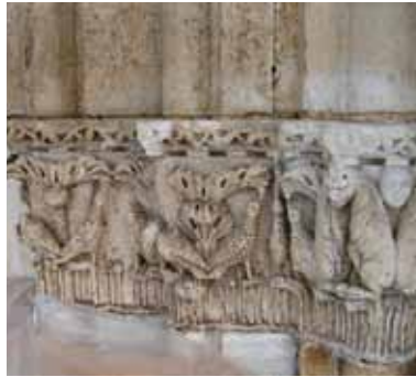
Foggia: Lucera Katedrali (M.S. Erken 16. Yüzyıl) Trani taşı, küçük tuğlalar, kumtaşının temizliği
