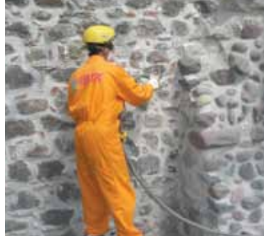
Kocaeli - Gölcük: Kazıklı Kervansaray (M.S.. 16. Yüzyıl) Yığma taş yüzeylerinin temizliği
